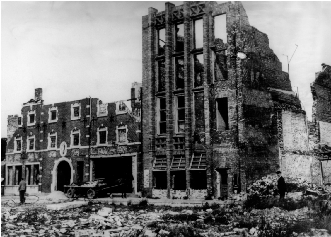
Zerstörungen in der Bollwerkstraße, Emden (1945)
