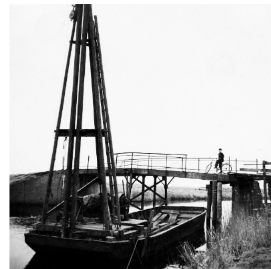
Eine Rammvorrichtung auf dem Rorichumer Tief
