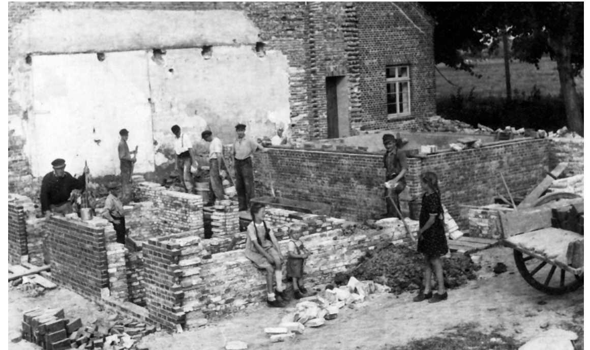
Beseitigung von Kriegsschäden: Auch am Buschplatz (jetzt Großterlinden) tat sich seinerzeit viel.
