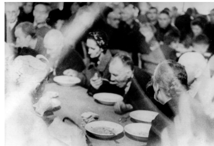
Speisung in einem Emden Bunker
