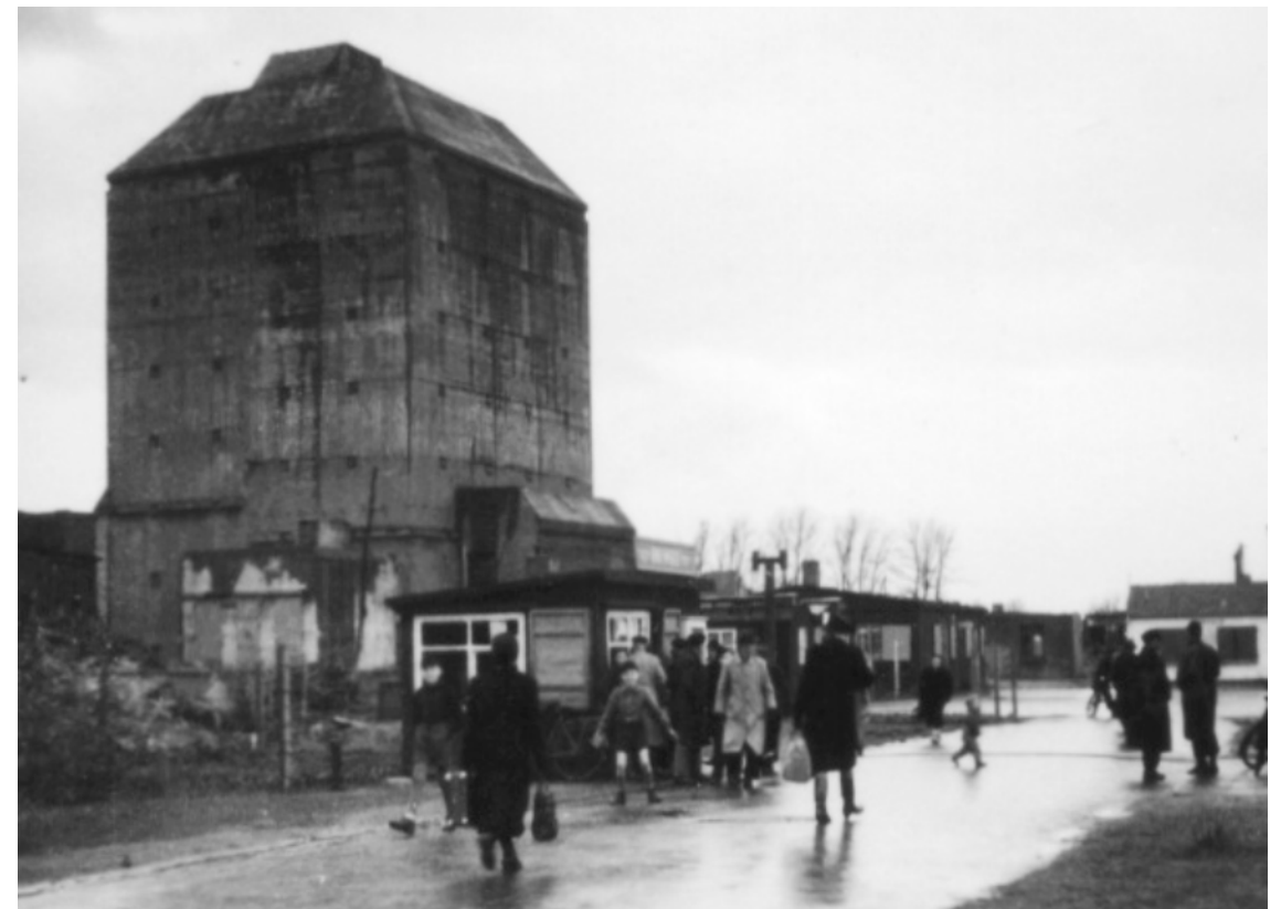
Einer von 35 großen Luftschutzbunkern, die ab 1940 in Emden gebaut wurden.
