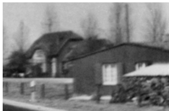
Die Südseite der Baracke mit dem Lott-Haus im Hintergrund. (Fotausschnitt von ca. 1962)
