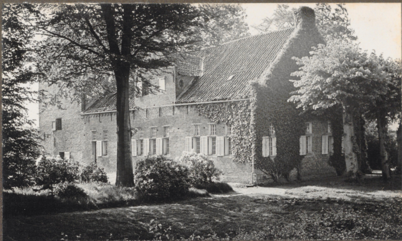
BLICK VON NORDWESTEN
