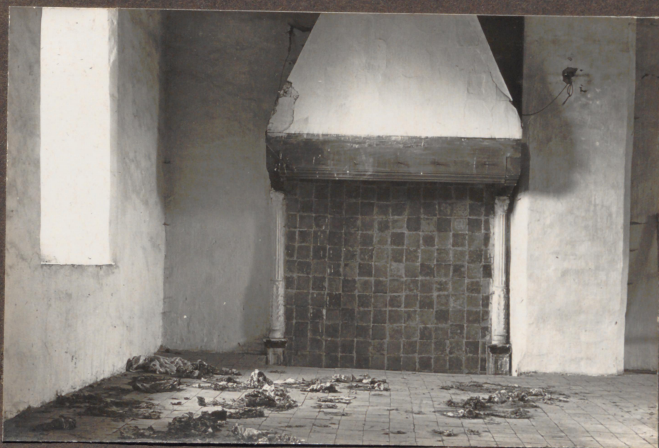
KAMIN IM 2. OBERGESCHOSS
