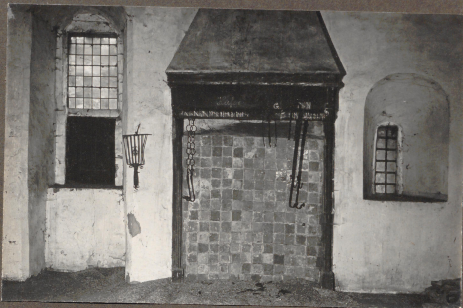
KAMIN IM 1. OBERGESCHOSS
