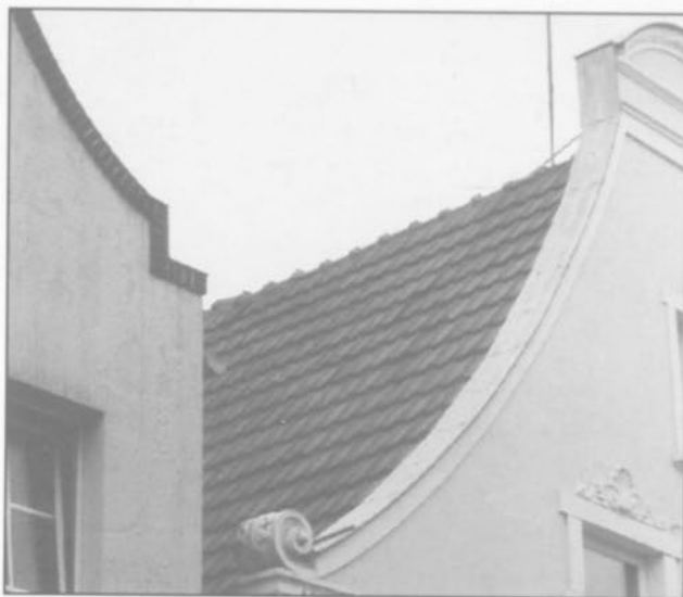
Zinkblechabdeckung an einem Glockengiebel
