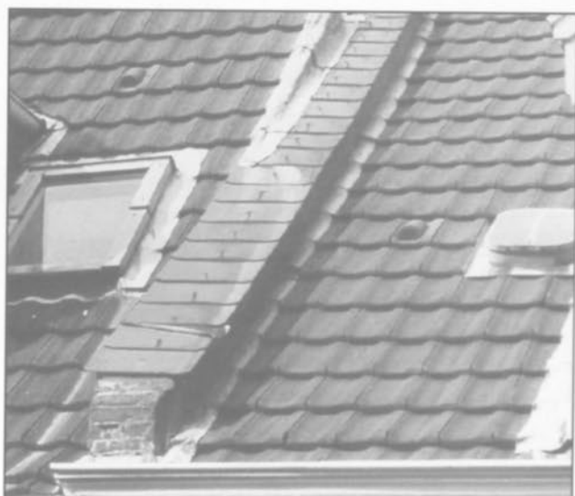
Zinkblechabdeckung an einem Glockengiebel
