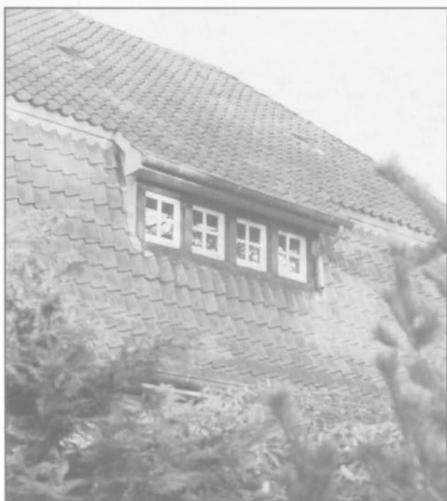
Schleppgaube an einem Mansarddach
