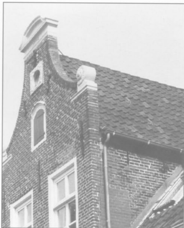
Zinkblechabdeckung an einem Glockengiebel
