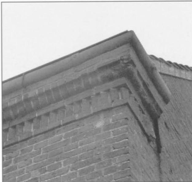
Rysum – Kunstvoll gemauertes Hauptgesims mit halb aufliegender Rinne
