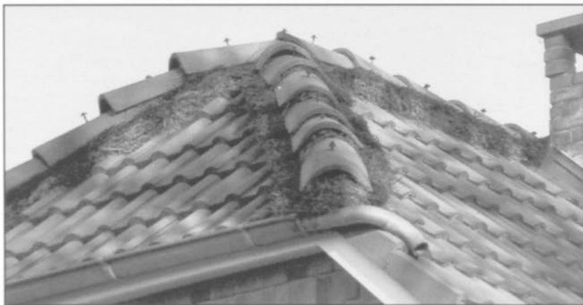
First bzw. Gratziegel mit Heidekraut unterlegt
