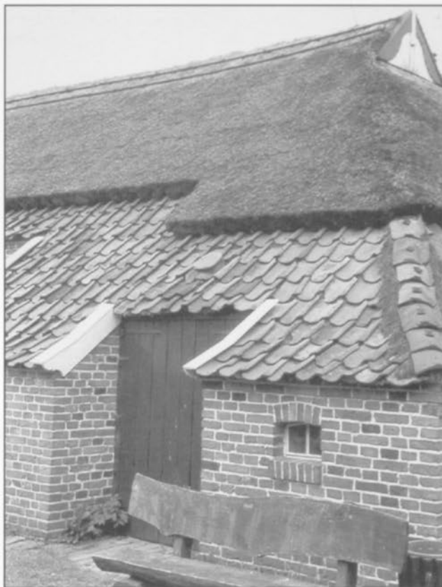
Teilansicht des Landarbeiterhauses im Moormuseum von Moordorf
