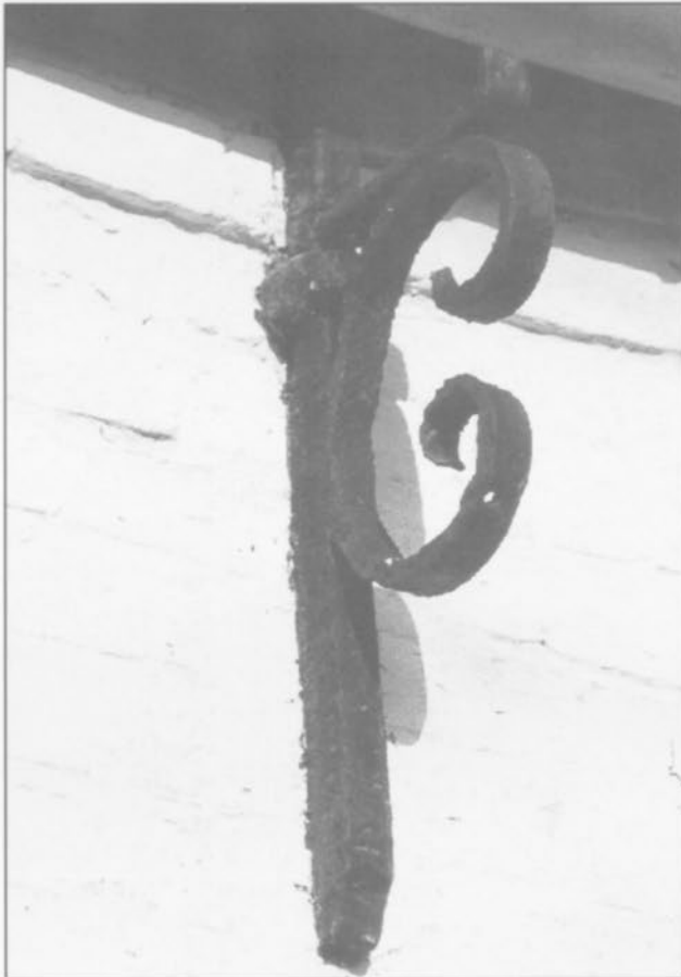
Neukamperfehn – Deckenbalkenanker, der zugleich Auflager für eine Kasten- oder Massivholzrinne war.
