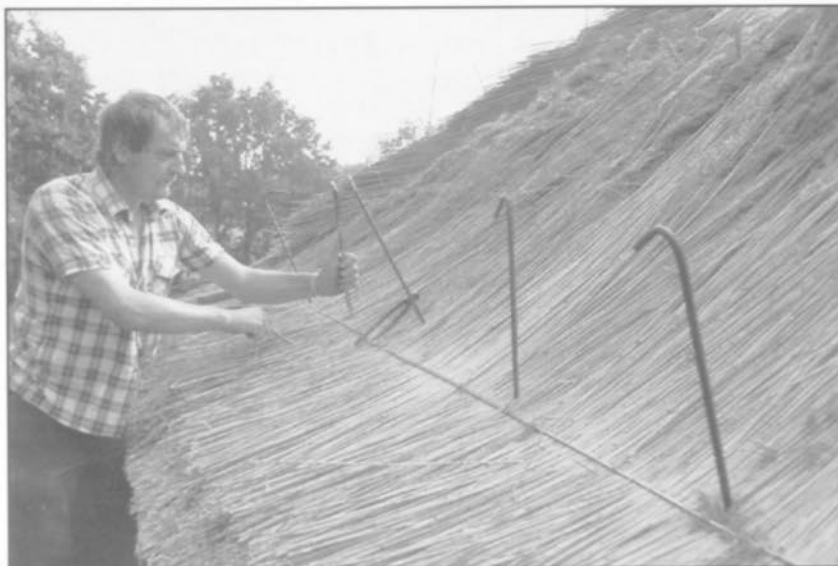
Arbeitsvorgang bei der Eindeckung der Walmdachfläche eines genähten Reetdaches
