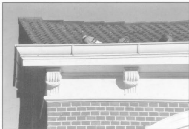
Aurich – Kastengesims mit Konsolen und halb aufliegender Rinne
