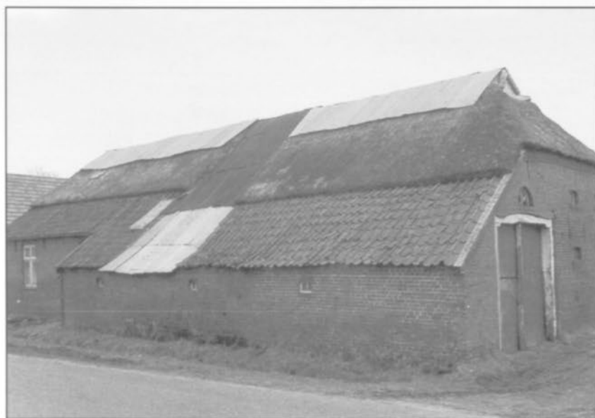
Das Dach als Baustoffsammlung
