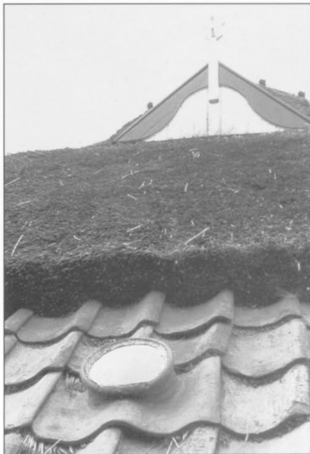
Das Foto zeigt eine seltene alte Form-Ziegel-Lichtöffnung am Landarbeiterhaus im Moormuseum in Moordorf
