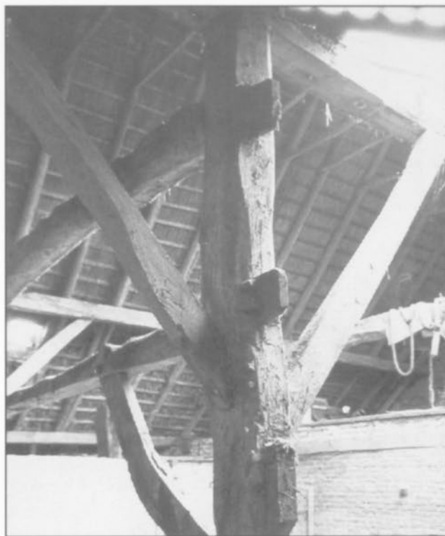
Stapelwerk mit doppeltem Ankerbalken (Foto: Rott)
