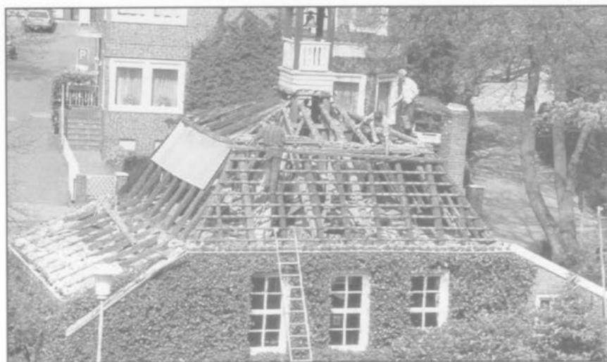
Das Pingel-Hus in Aurich, ein Mischdach bestehend aus Walmmansarde und Pultdächern
