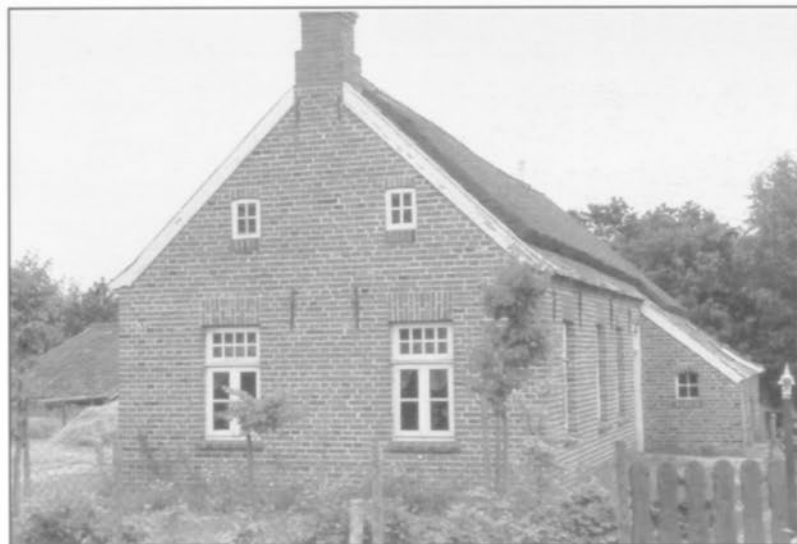
Typisch für Häuser mit übergreifender Dachfläche ist die weiße Windfeder. Hier ein Beispiel aus Moordorf.
