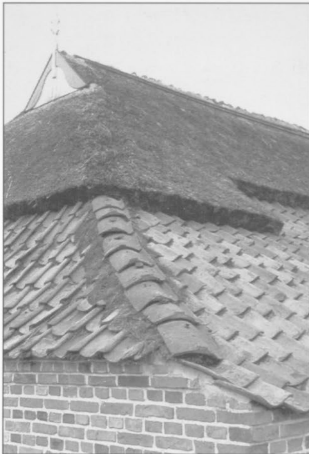
Alte Form der Grateindeckung mit herumgedrehten Pfannen
