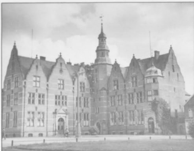
Landschaftsgebäude in Aurich
