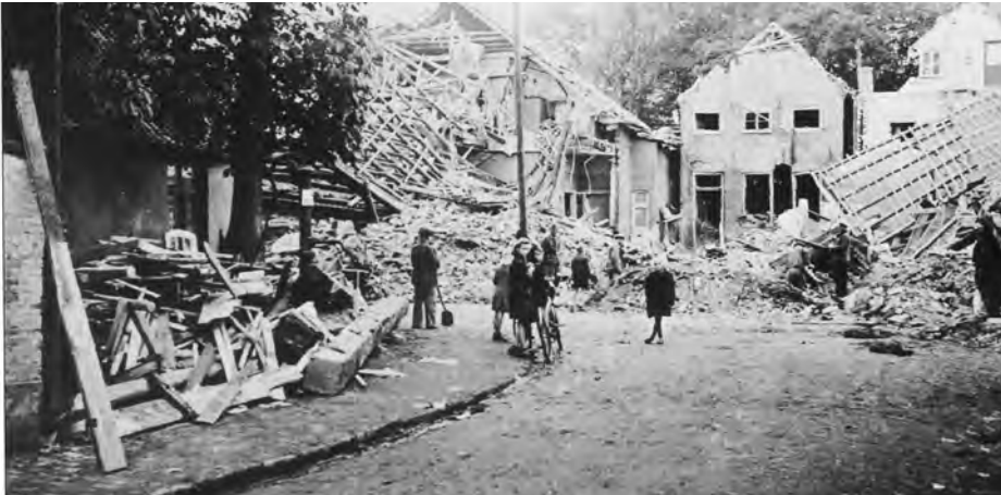
Abb. 12: Nach dem Luftangriff auf Esens am 27. September 1943 lagen große Teile der Stadt in Trümmern: Blick von der Jücherstraße auf zerstörte Häuser an der Butterstraße (Stadt Esens, Sammlung Albrecht Gerdes)
