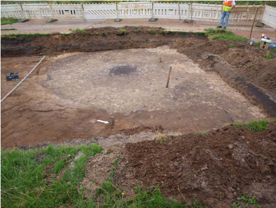
Abb. 10: Lütetsburg (12). Der Brunnen bzw. die Baugrube im Planum. (Foto: Chr. Hilgers)
