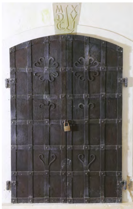
Abb. 11: Neugestalteter Zugang zur Gruft der Familie Löling in der nordwestlichen Ecke der Krypta (Foto: Stefan Krabath, NihK Wilhelmshaven)
