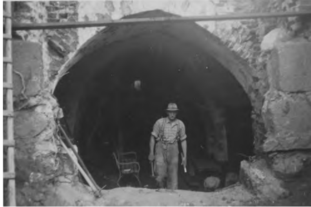
Abb. 8: Der Arbeiter Reinhard Heijenga im freigelegten Südeingang zur Krypta der ref. Kirche Leer am Westerende ca. 1957 (Foto: Friedrich Voorwold, Leer)
