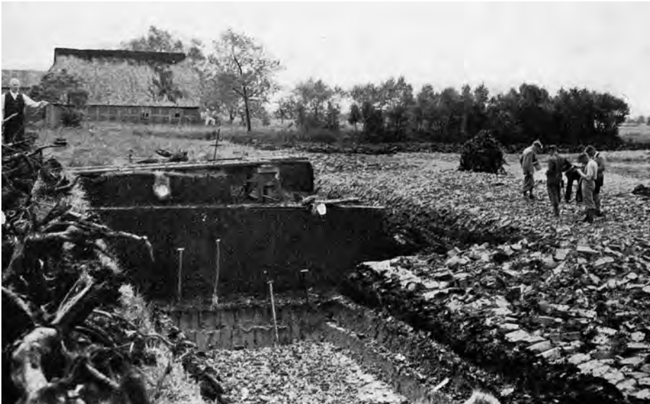
Abb. 6: Das Kleischießen in Aktion. Unter dem dunklen Schwarztorf liegt Bruchwaldtorf, aus dem die Hölzer links im Bild stammen. Der unten liegende helle kalkhaltige Klei wurde rechts über dem Bruchwaldtorf und dem eingeworfenen Weißtorf auf das Feld verteilt (Foto: G. Wagner 1936, aus: Schütte, S. 138).
