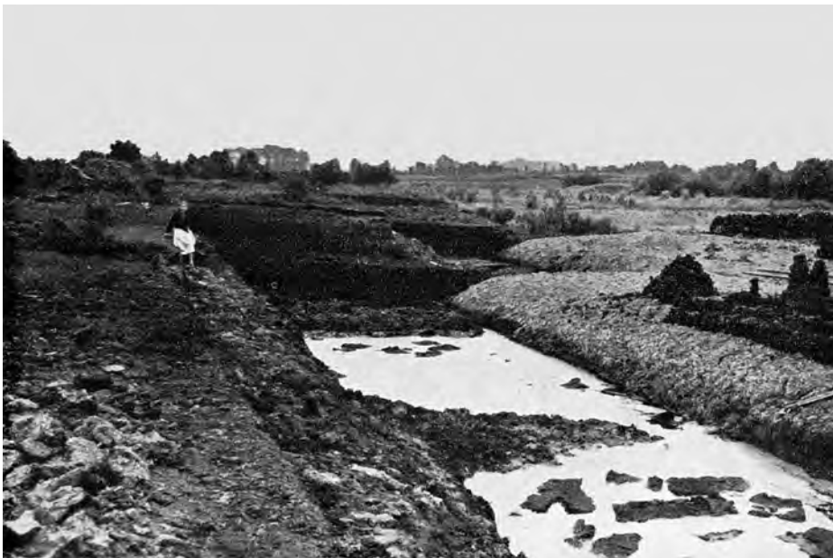
Abb. 8: Ähnlich wie zu Abb. 7. Die Grube des Kleischießens ist vorübergehend vollgelaufen. Zu erkennen sind die großen Flächen des kleibedeckten neugewonnenen Ackerlandes (Foto: G. Wagner 1937, aus: Schüttele, S. 137).
