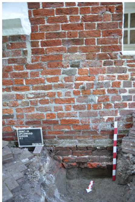
Abb. 25: Upleward (26). Profil des Fundamentes an der Nordseite der Kirche (Foto: I. Reese).
