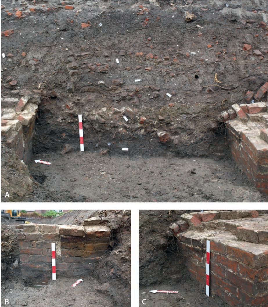
Abb. 8: Borssum (7). A Ansatz des Entlastungsbogens im Mauerverband von Bef. 3 und 2. Darüber sind auch zwei Lagen aus bogenförmig angeordneten Katzenköpfen und Backsteinen zu erkennen, die den ehemaligen Bogenscheitel zu markieren scheinen, B Ansatz des Bogens an Bef. 3, C Ansatz des Bogens an Bef. 2. (Fotos: W. Schwarze)
