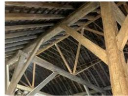
TRAGSTRUKTUR: HOLZSKELETTBAUWEISE MIT STECKVERBDINUNGEN
