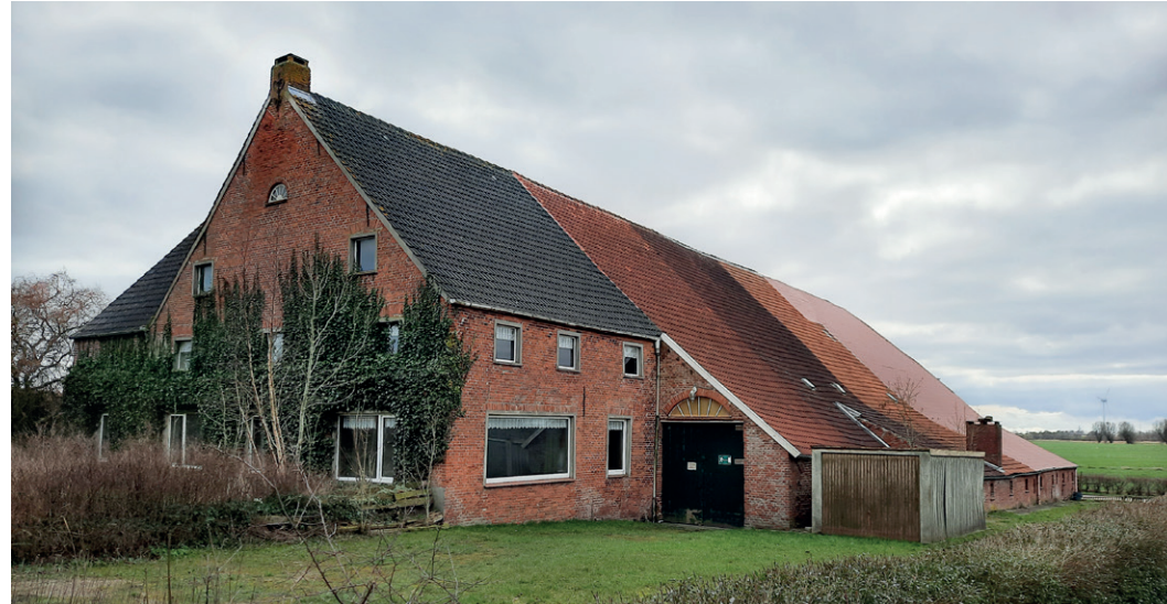
Abb. 67 Gulfhaus mit erneuerten Wohnhausfassade
