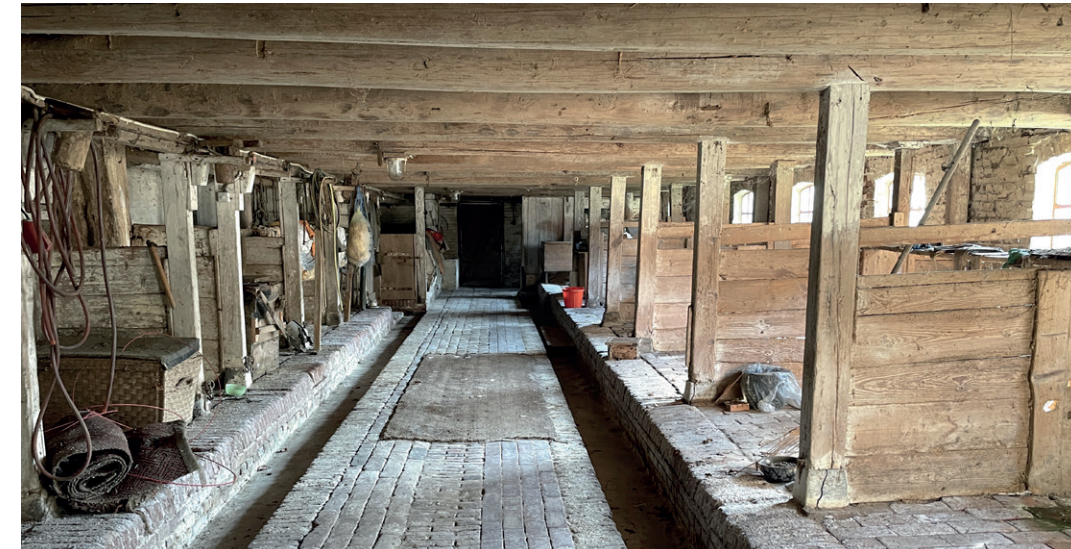
Abb. 58 Kuhstall mit gepflastertem Boden und den Gropen (Rinnen für die Jauche)
