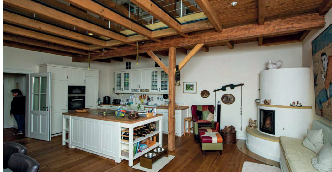
Abb. 27 Glasdecke zur Belichtung der Wohnung im ehemaligen Kuhstall, Foto: Ute Bruns
