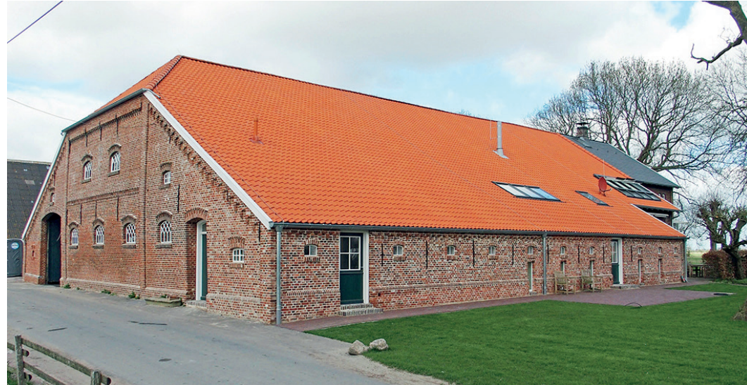
Abb. 24 Neu aufgemauerte Scheunenwände mit historischen Klinkersteinen
