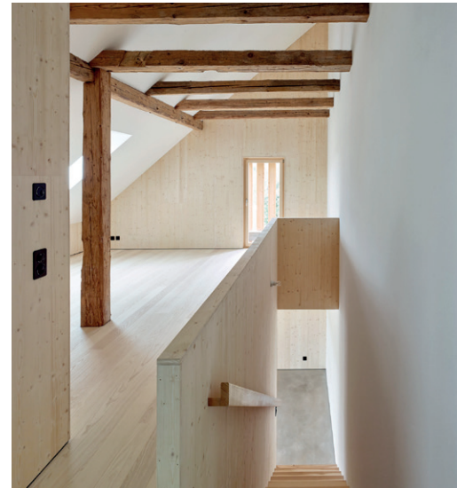
Abb. 43 Alte Tragstruktur vs. neuen Einbauten
